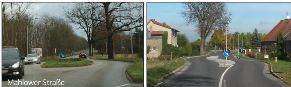
**Abb. 21** Beispiele Ortseingangsgestaltung mit Fahrstreifenversatz
